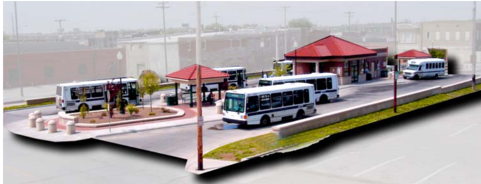
Figura 4: Centro de Transferencia de Centro de la ciudad en 6 th y Angelique
